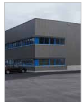
Die neue Produktionshalle fügt sich durch die Skelettbauweise und Trapezblechverkleidung gut in das Industriegebiet Klarenbrunn ein.
