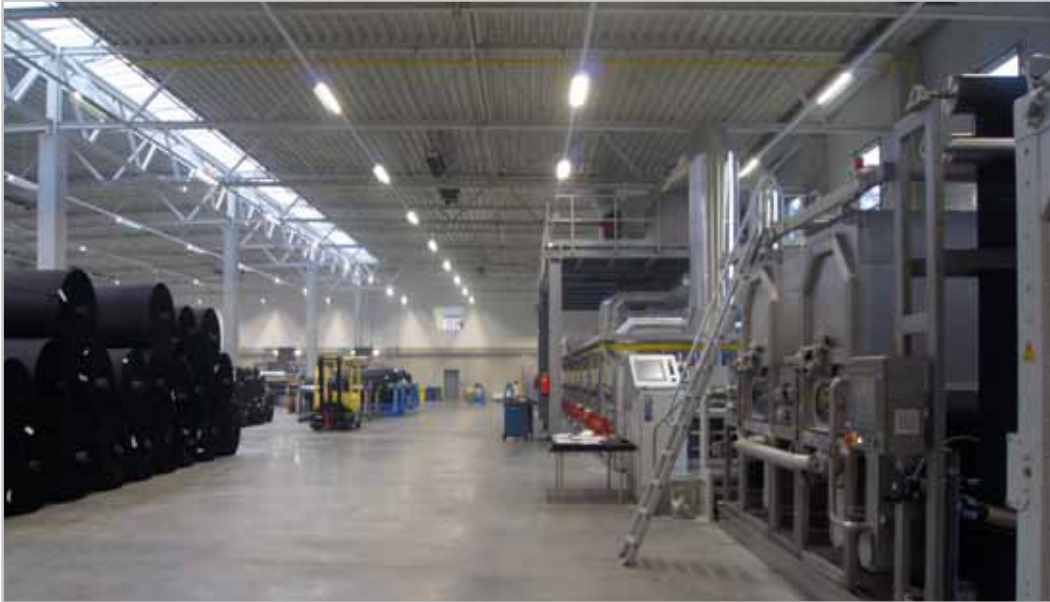
3.000 Quadratmeter Fläche umfasst die neue Industriehalle.
