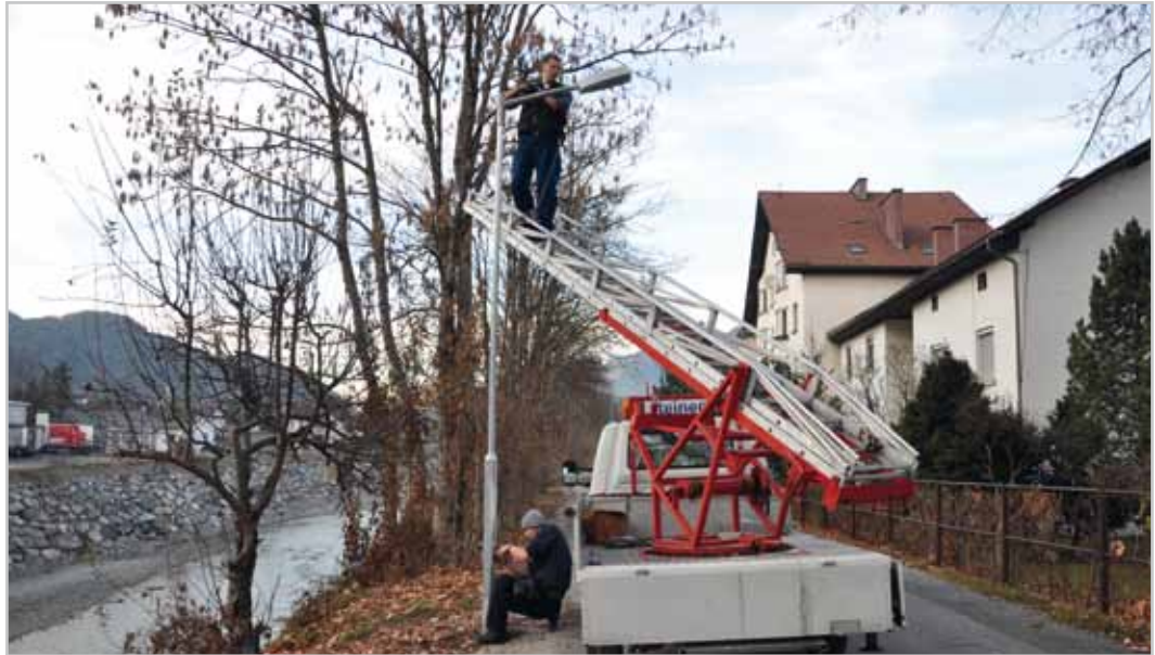
Der Obere Illrain wurde mit energieeffizienten Leuchtmitteln ausgestattet.
